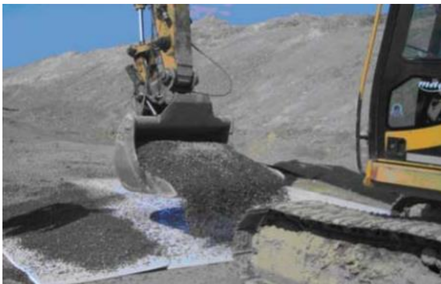
Рисунок 6.4 – Укладка пенополистирольных теплоизоляционных плит (XPS), Норвегия [125]
