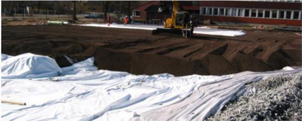
Рисунок 1.15 – Устройство морозозащитного слоя с использованием керамзитового гравия (LWCA) [108]
