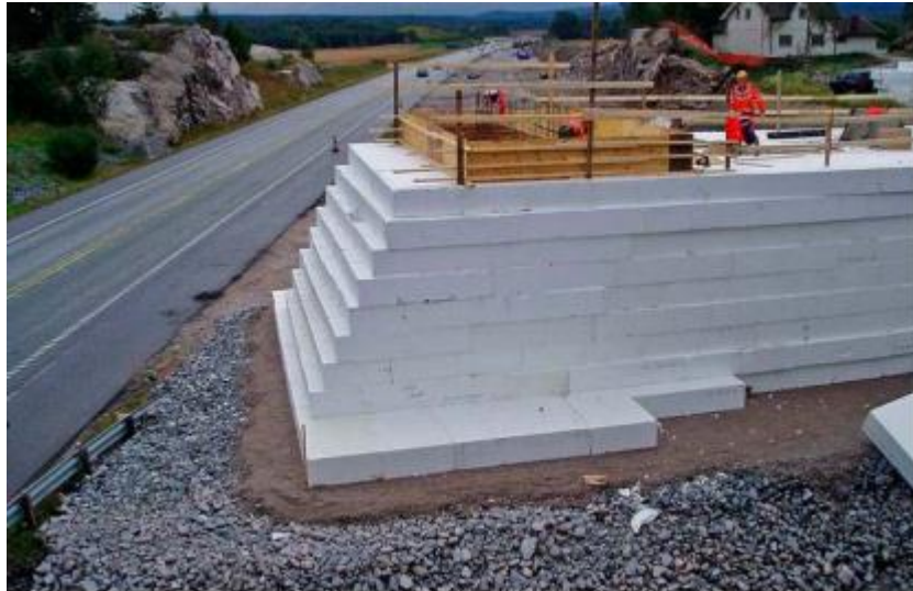
Рисунок 1.15 – Устройство морозозащитного слоя с использованием керамзитового гравия (LWCA) [108]
