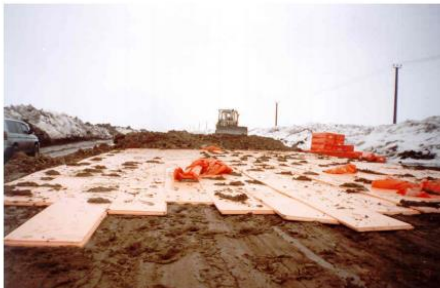
Рисунок 1.6 – Процесс укладки пенополистирольных плит в конструкцию автомобильной дороги
